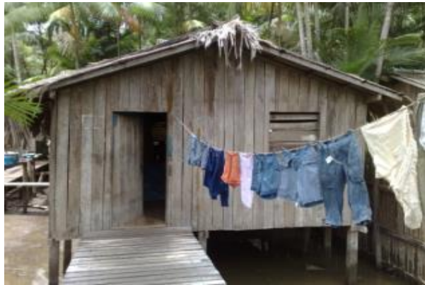
Figura 07: Exemplos de ripas de sentido vertical e com caimento lateral do telhado na Vila do Elesbão
