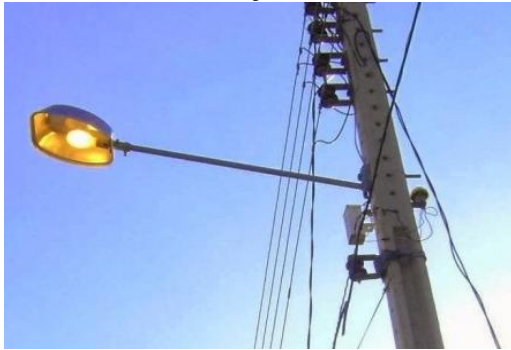
Figura 2.24 – Estrutura de Iluminação Pública e Braço
