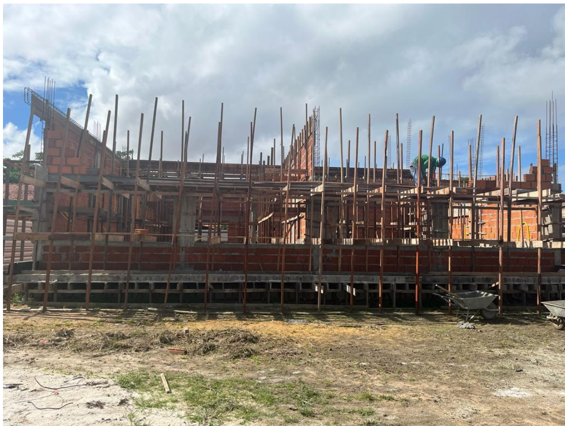
Foto 25 – elevação de alvenaria (fevereiro de 2023)
