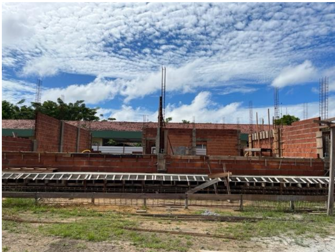
Foto 21 – laje da vista frontal/fachada 16.01.2023
