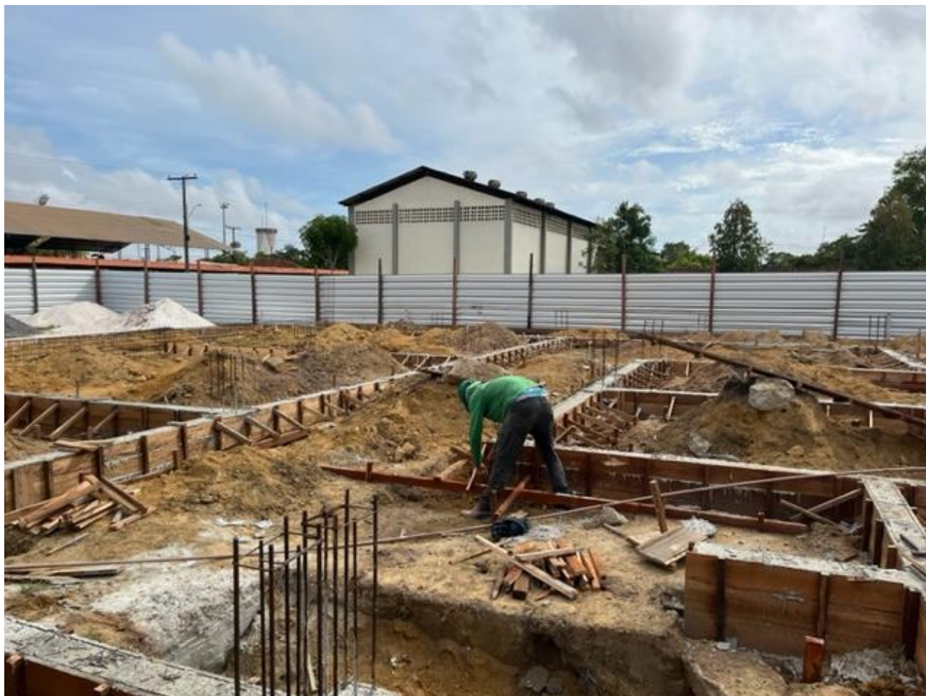
Foto 11 – concretagem vigas baldrame
