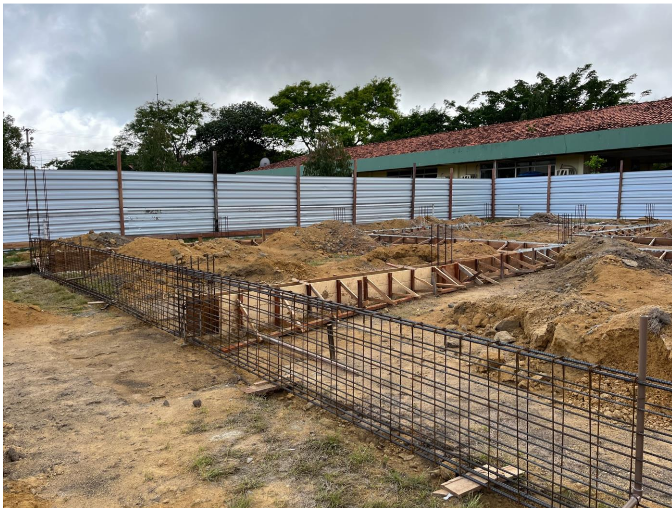
Figura 4 – armação da Viga 4
