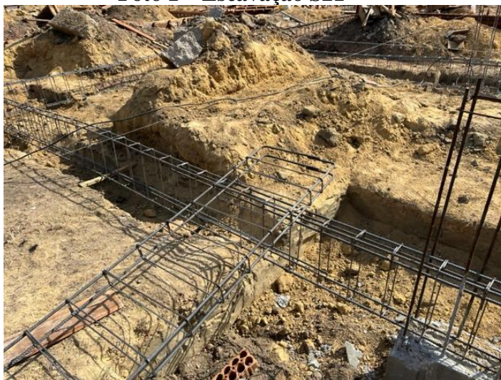
Foto 2- Armação da vigas
