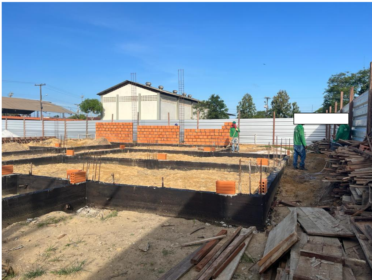
Foto 14 – impermeabilização vigas baldrame 12.12.2022
