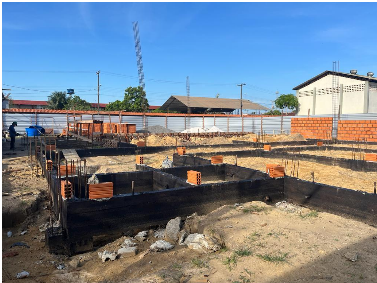
Foto 16 – impermeabilização vigas baldrame 12.12.2022
