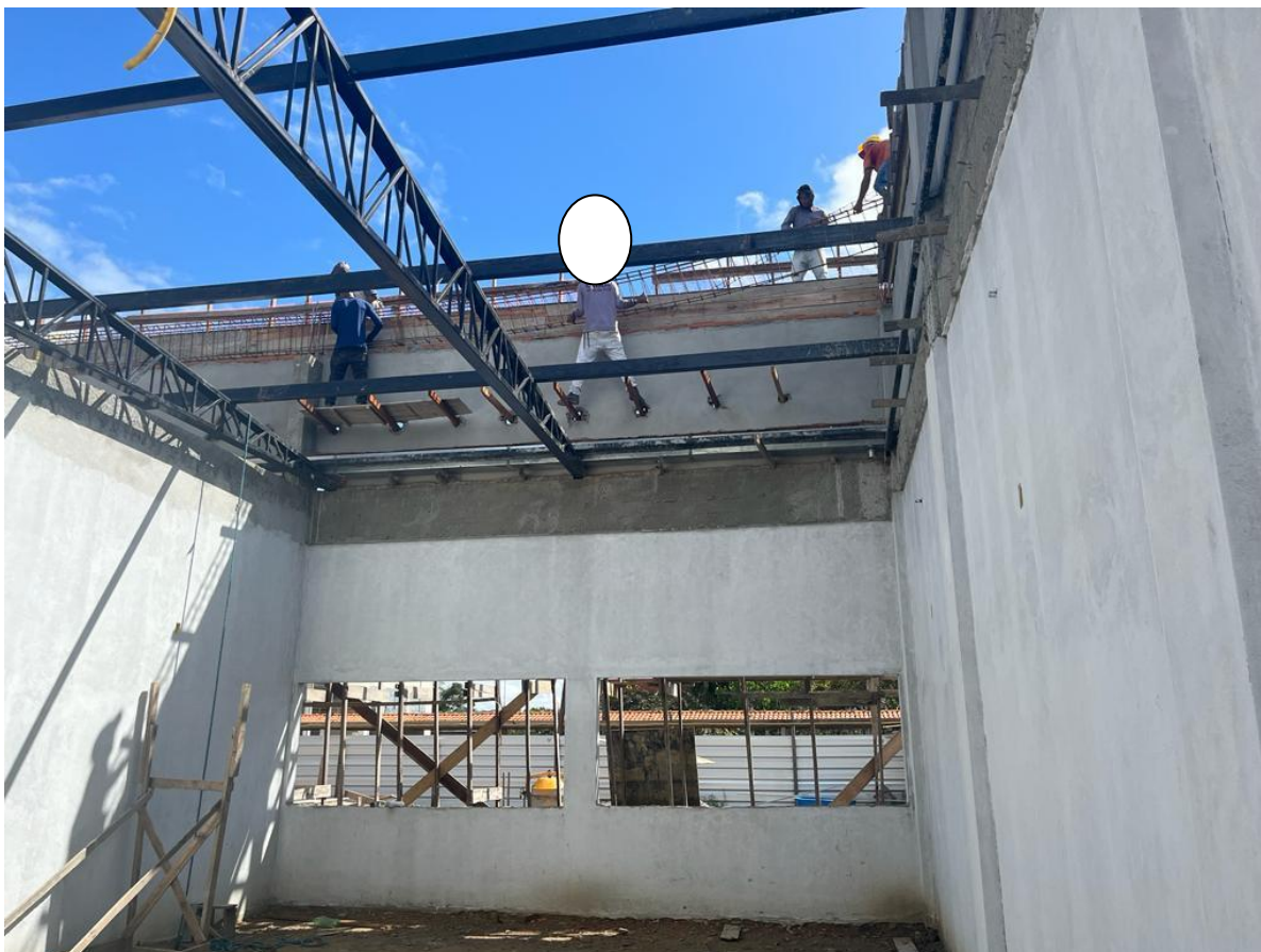
Foto 4 – armação da viga e laje da cobertura.
