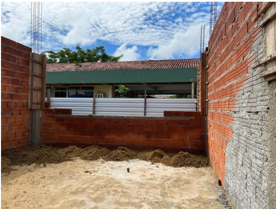
Foto 20 – elevação alvenaria e aterro 16.01.2023
