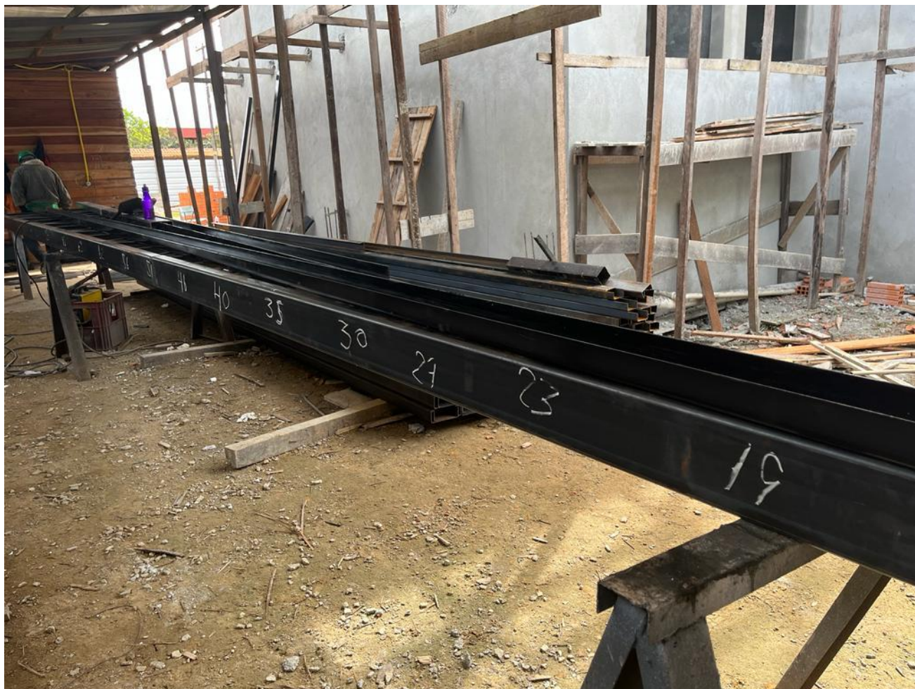
h.2 – estrutura metálica da cobertura
