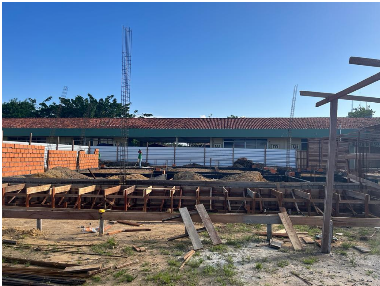
Foto 17 – forma viga 4 baldrame 12.12.2022
