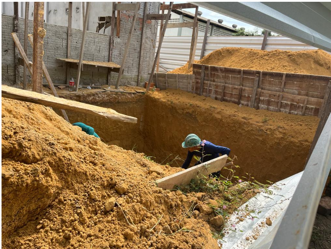
h.1 – escavação da cisterna
