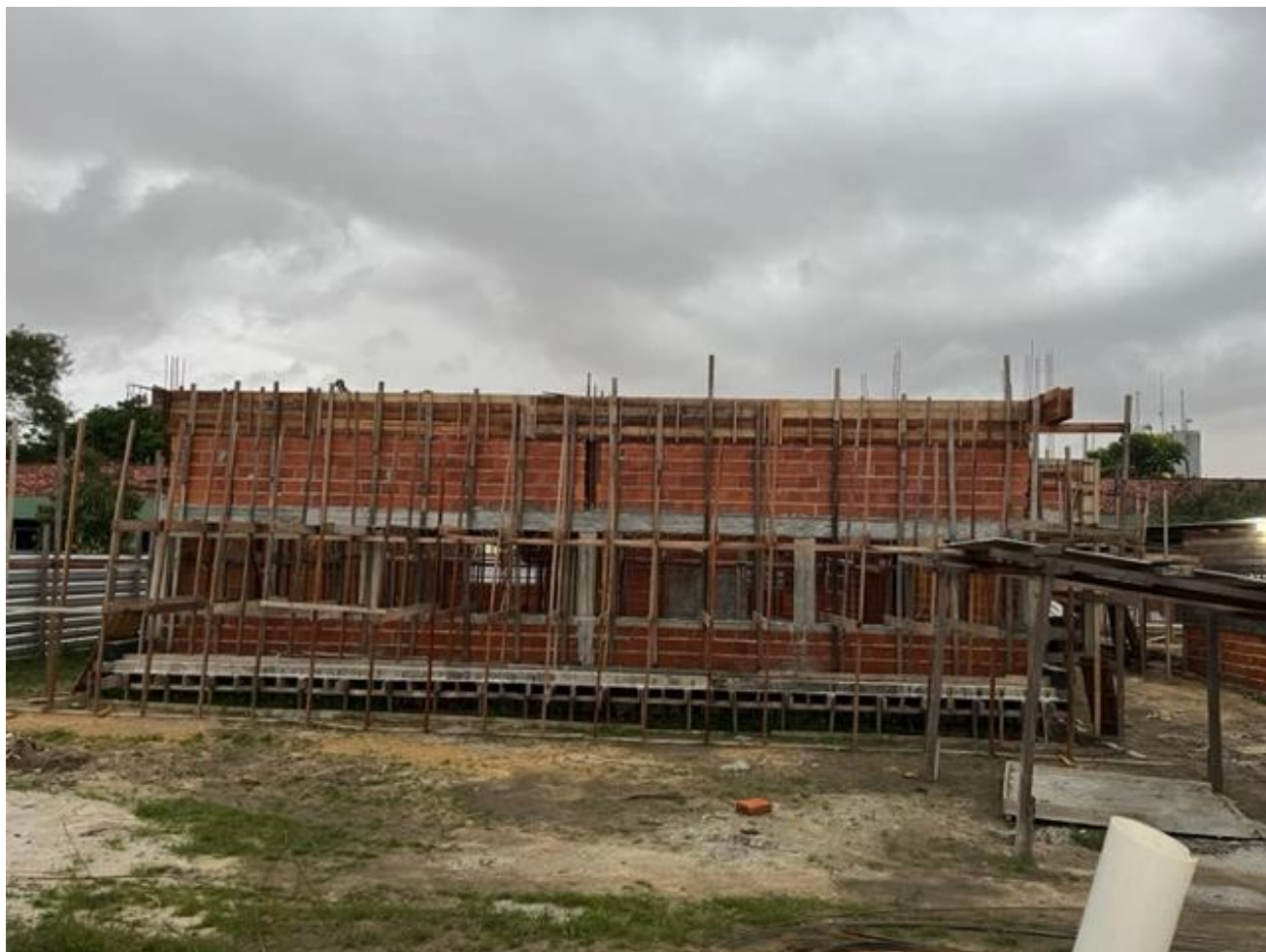
Foto 26 – elevação de alvenaria (06 de março de 2023)
