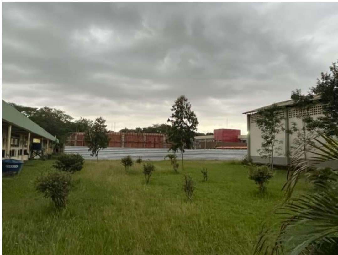
Foto 27 – elevação de alvenaria (06 de março de 2023)
