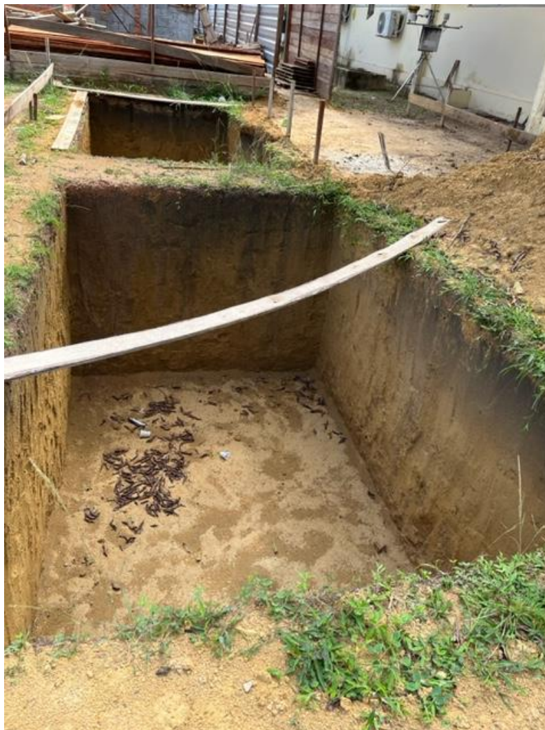
Foto 22 – escavação fossa filtro 16.01.2023
