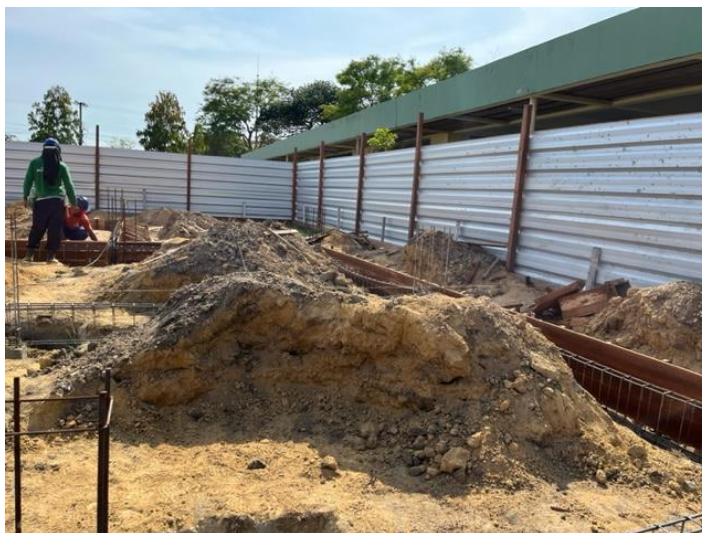
Foto 5 – Forma e armação das vigas
