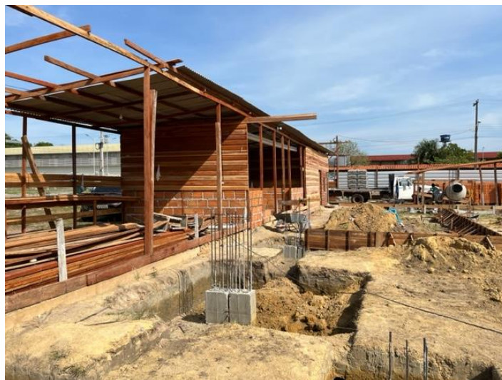
Foto 3 - Canteiro de obras
