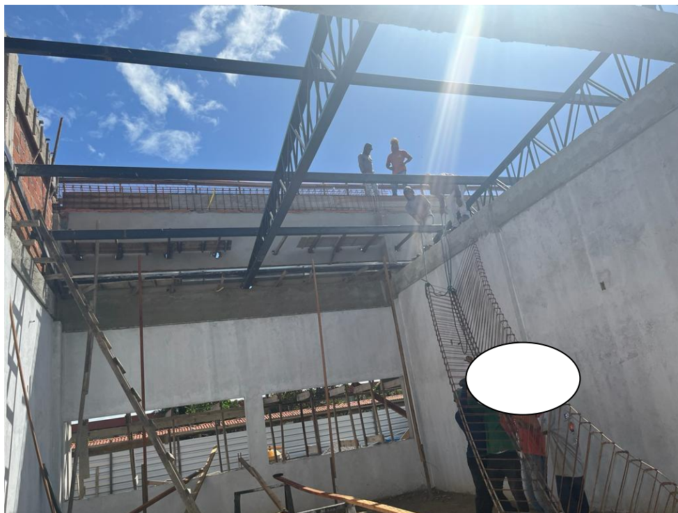
Foto 1 – armação da estrutura
