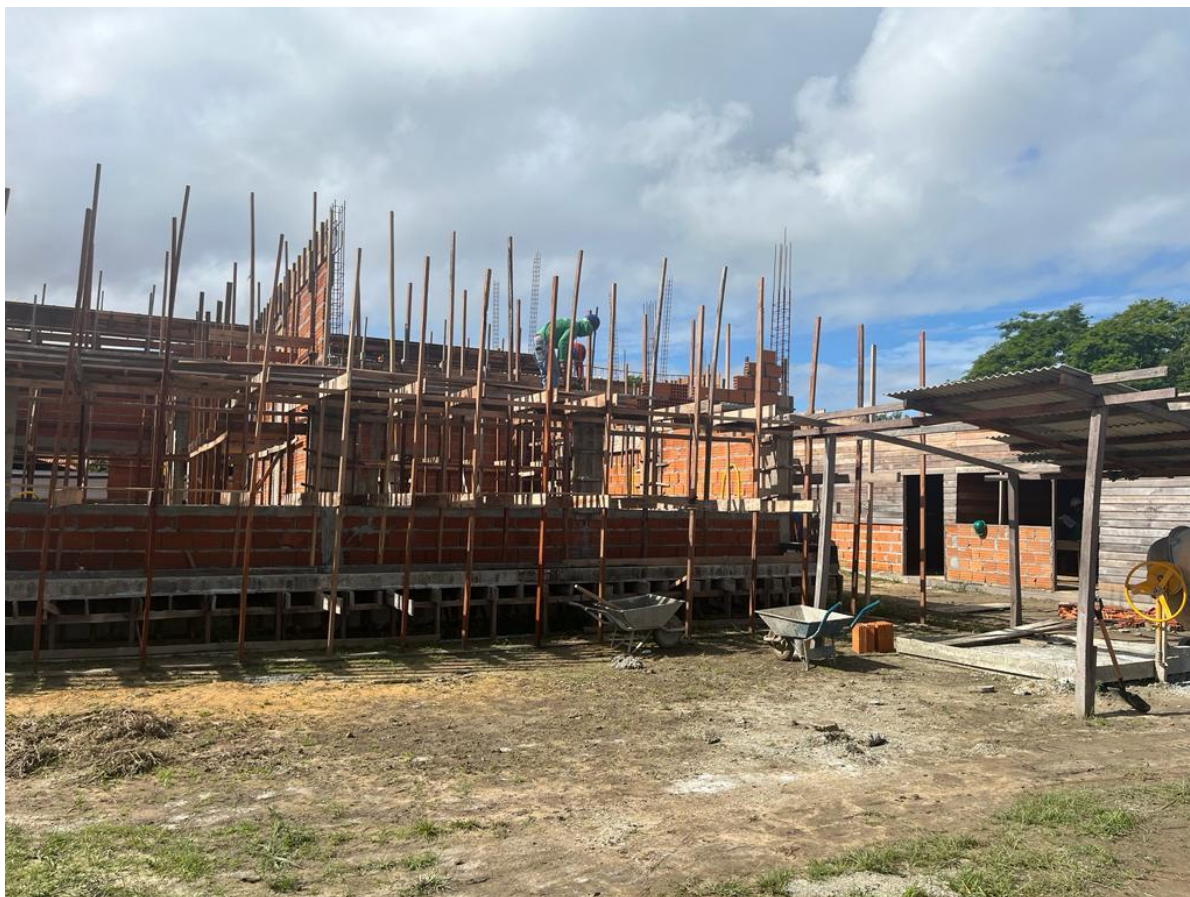
Foto 24 – elevação de alvenaria
