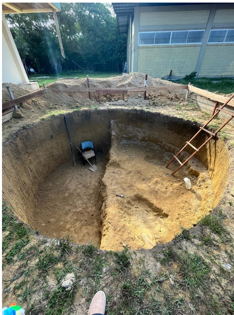
Foto 12 – escavação do sumidouro 12.12.2022
