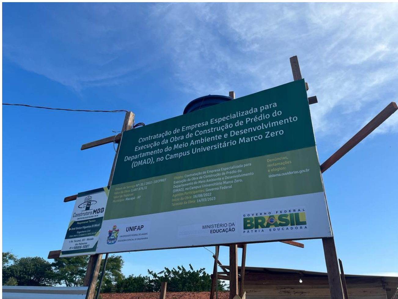
Foto 18 – correção da placa da obra 12.12.2022
