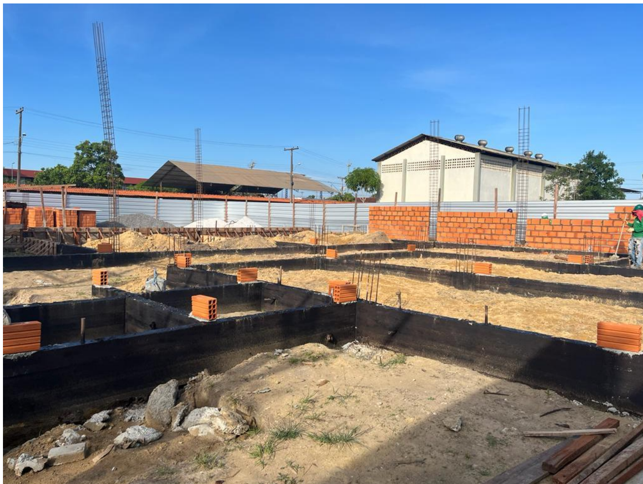
Foto 15 – impermeabilização vigas baldrame 12.12.2022
