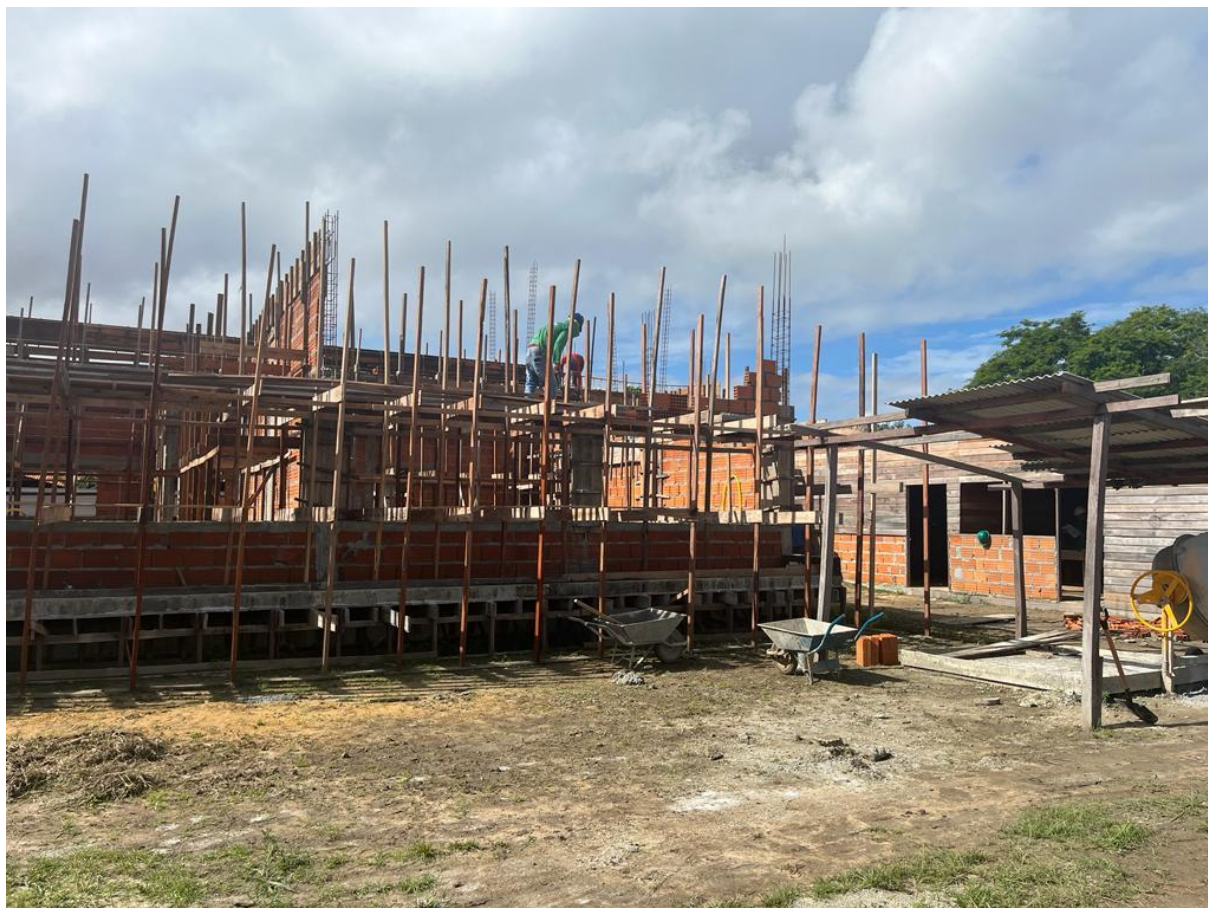
Foto 23 – elevação de alvenaria
