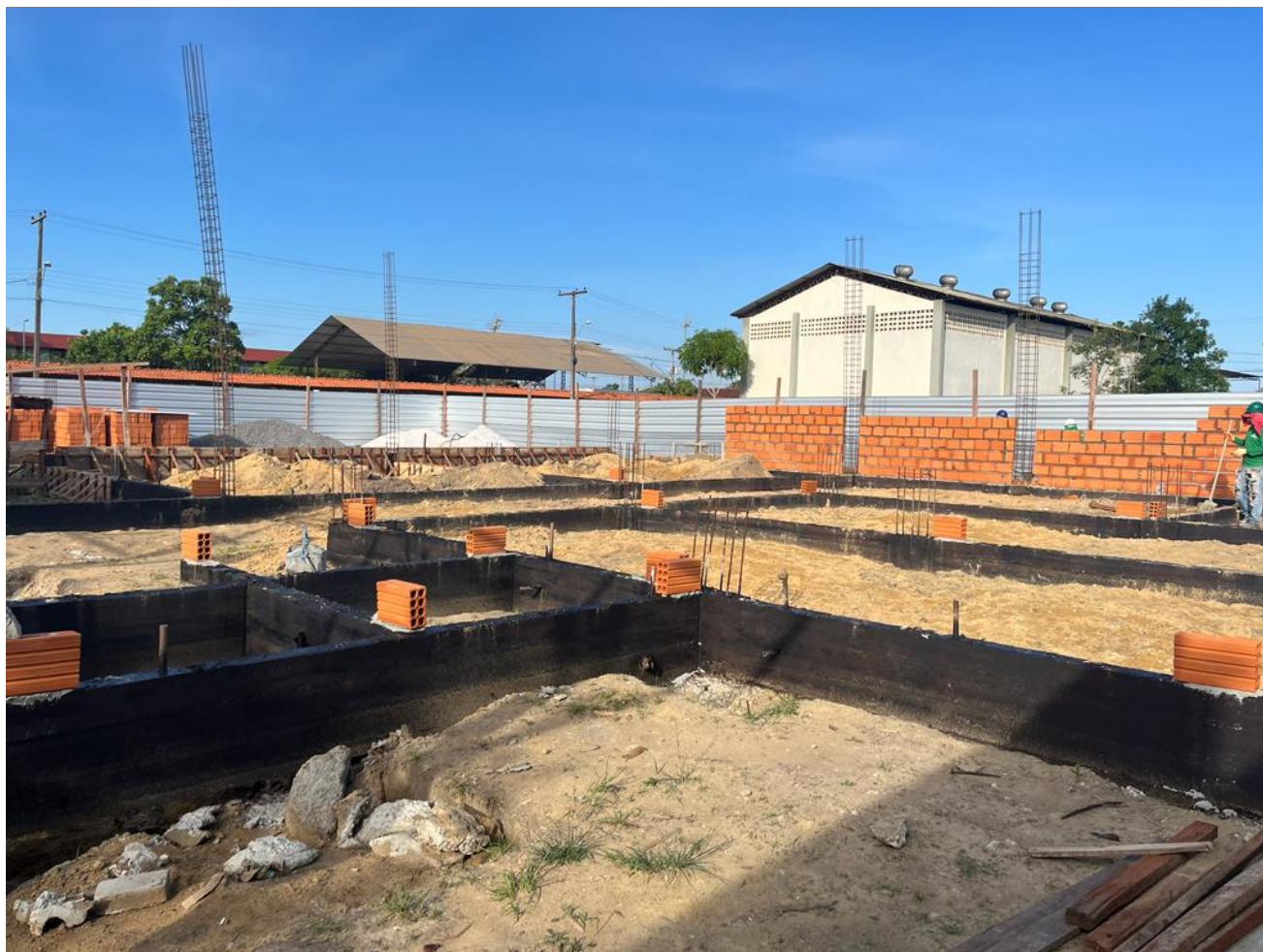
Foto 15 – impermeabilização vigas baldrame 12.12.2022
