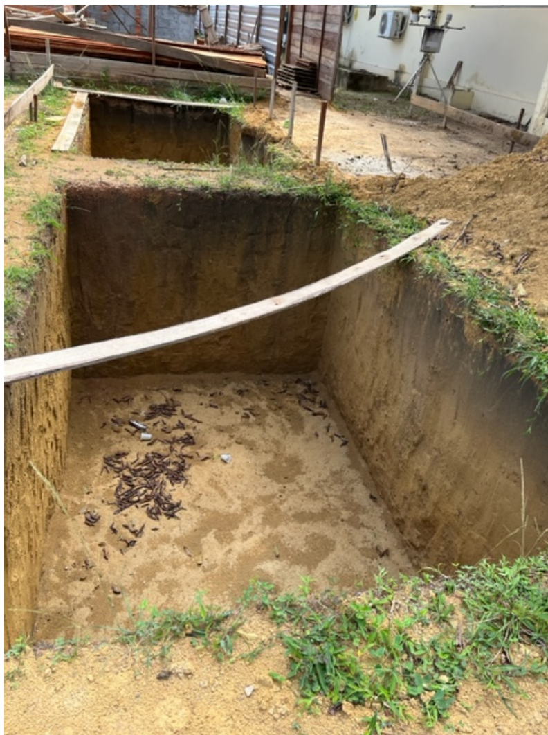
Foto 22 – escavação fossa filtro 16.01.2023
