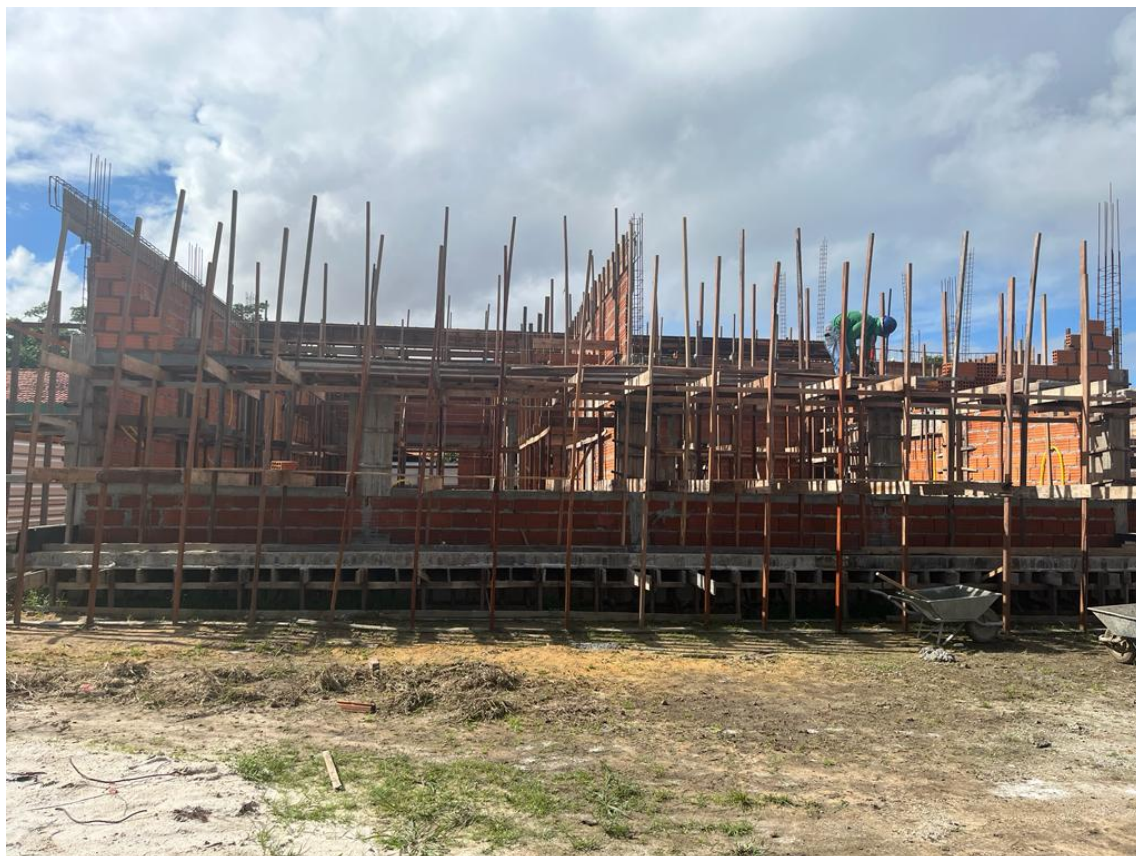
Foto 25 – elevação de alvenaria (fevereiro de 2023)
