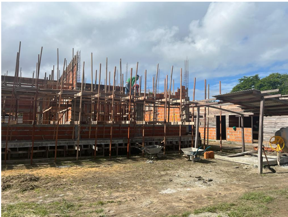
Foto 23 – elevação de alvenaria
