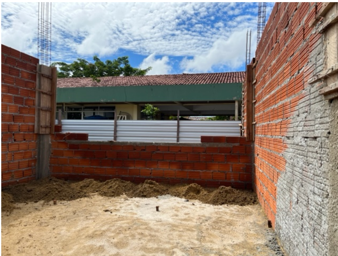
Foto 20 – elevação alvenaria e aterro 16.01.2023
