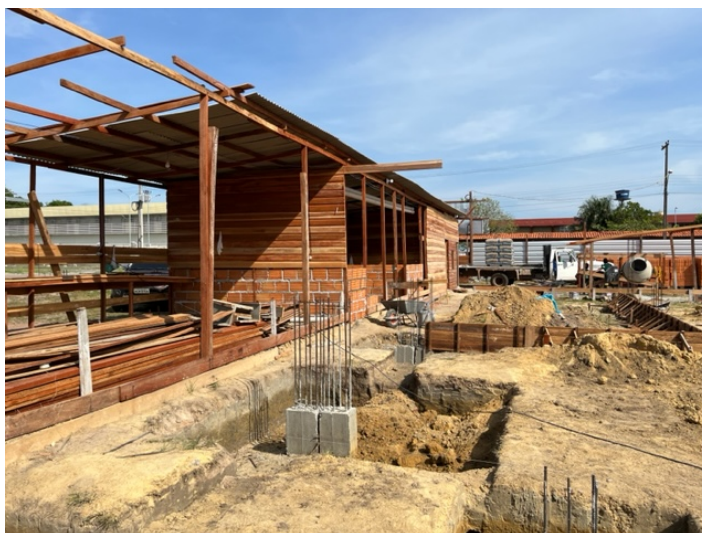
Foto 3 - Canteiro de obras
