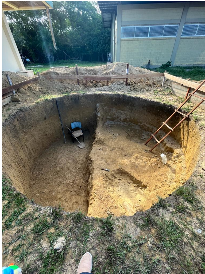
Foto 12 – escavação do sumidouro 12.12.2022
