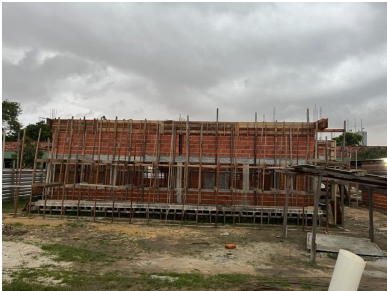
Foto 26 – elevação de alvenaria (06 de março de 2023)
