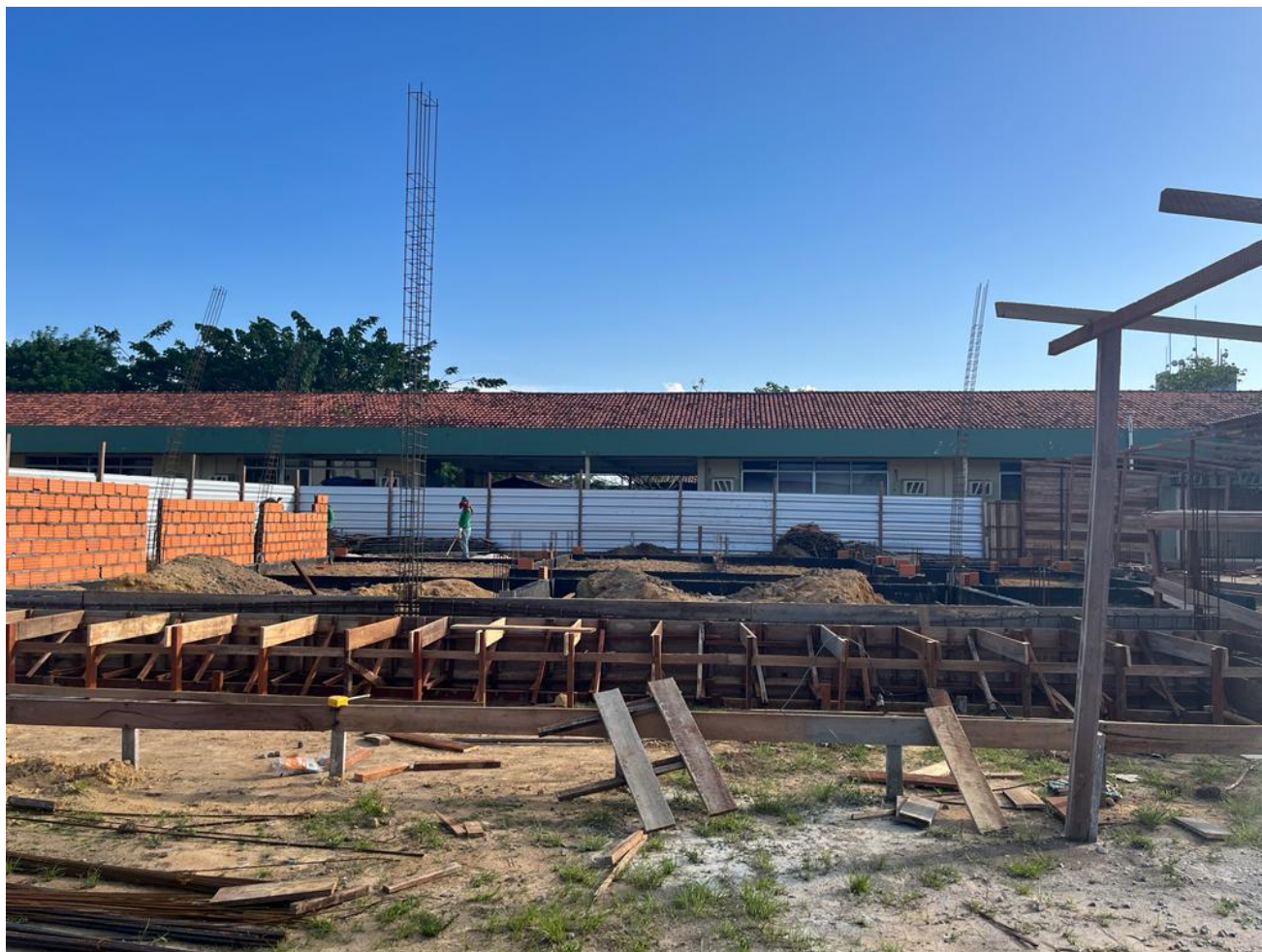
Foto 17 – forma viga 4 baldrame 12.12.2022
