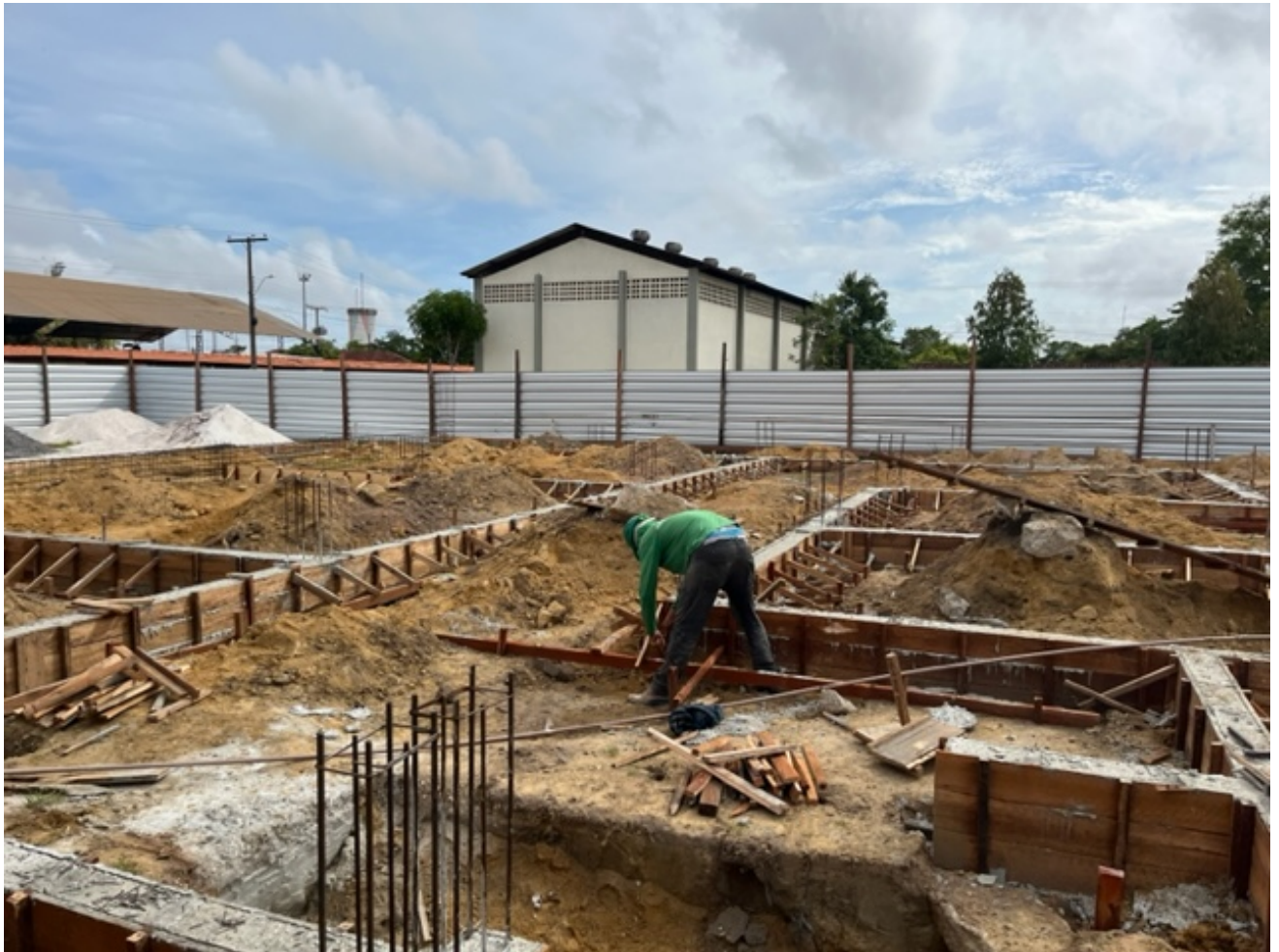
Foto 11 – concretagem vigas baldrame
