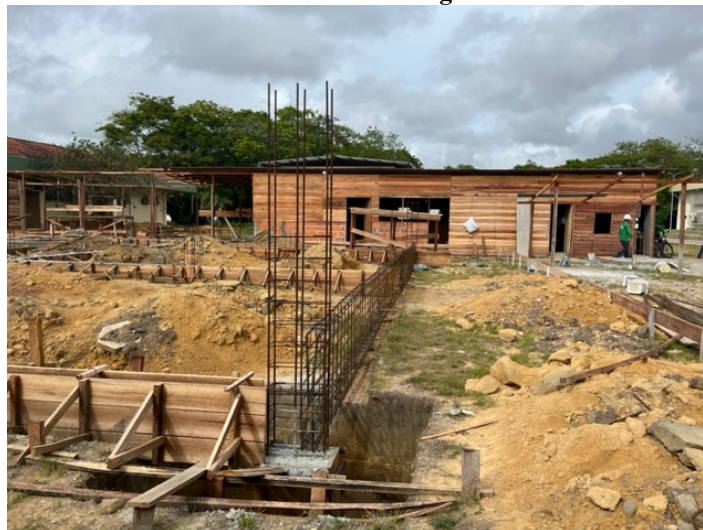
Foto 7 – armação viga 4
