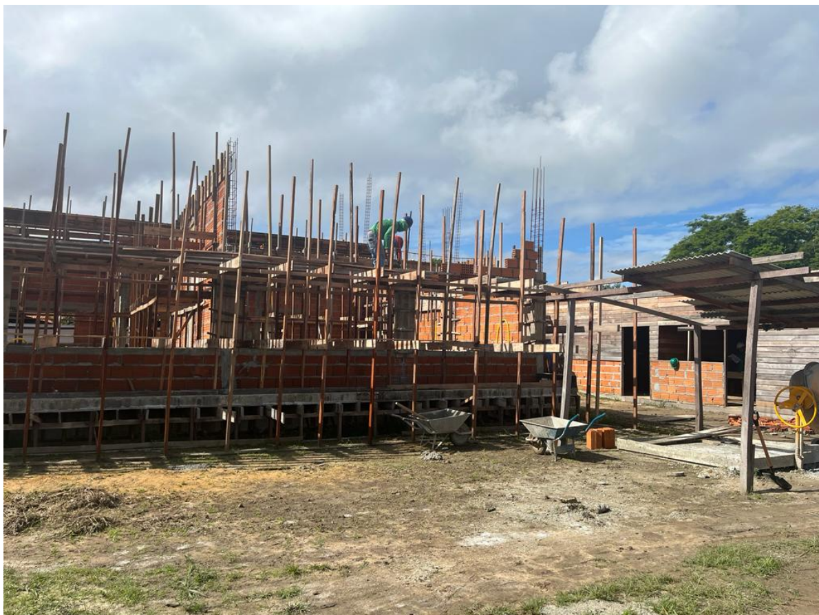
Foto 24 – elevação de alvenaria
