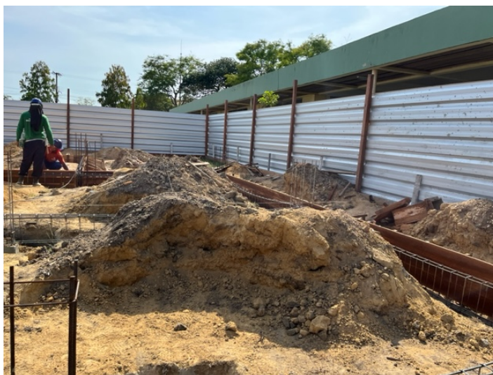
Foto 5 – Forma e armação das vigas
