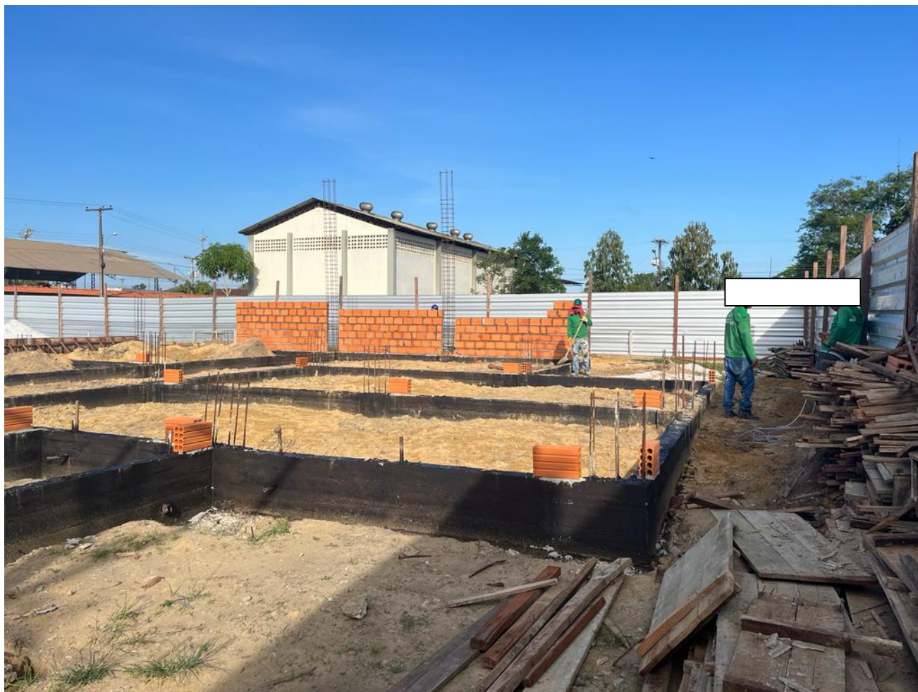
Foto 14 – impermeabilização vigas baldrame 12.12.2022
