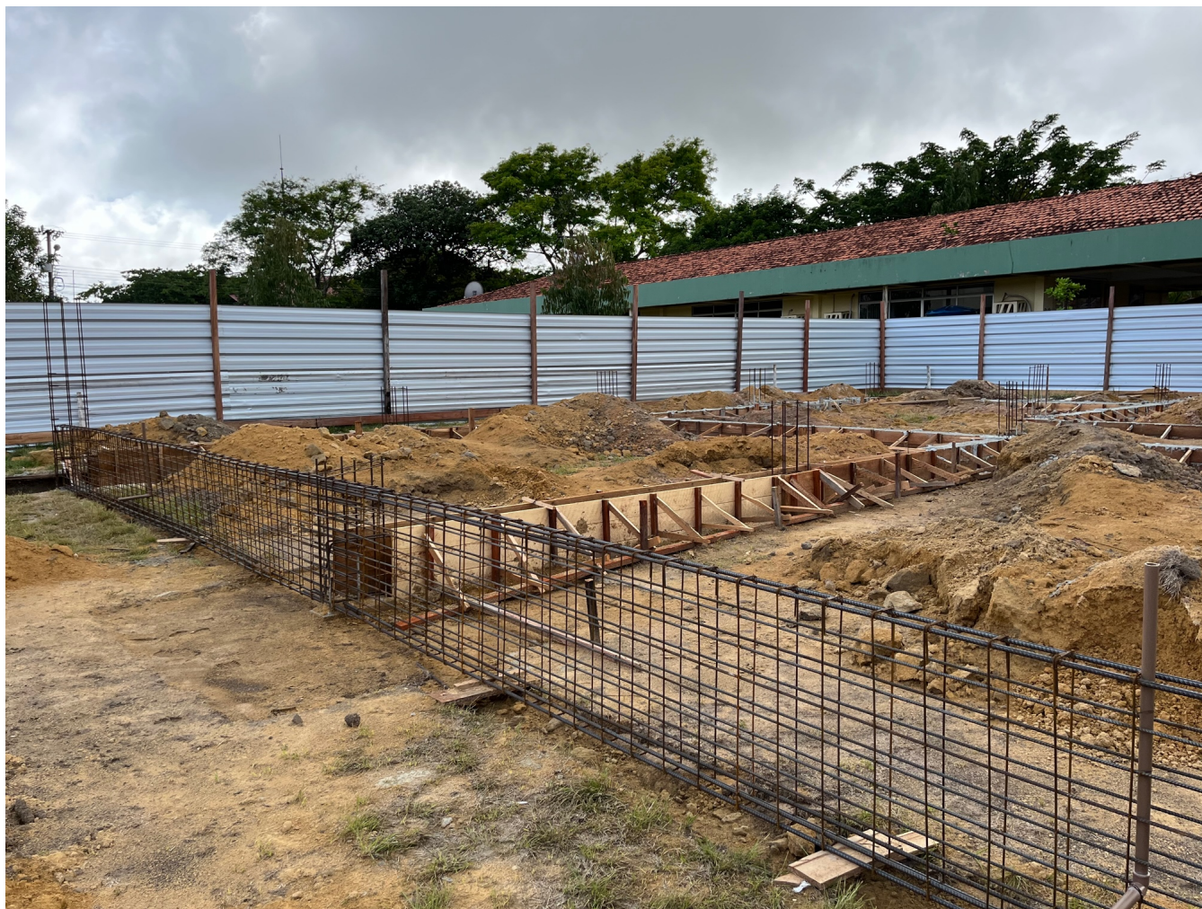
Figura 4 – armação da Viga 4
