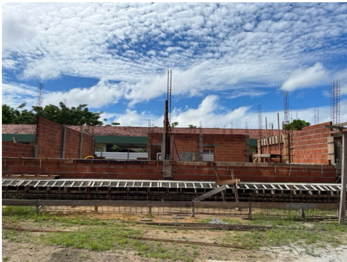
Foto 21 – laje da vista frontal/fachada 16.01.2023
