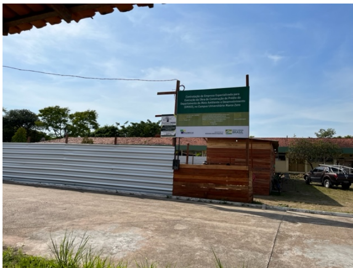
Foto 4 – Placa da obra
