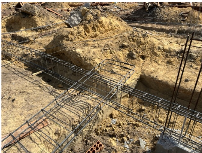
Foto 2- Armação da vigas
