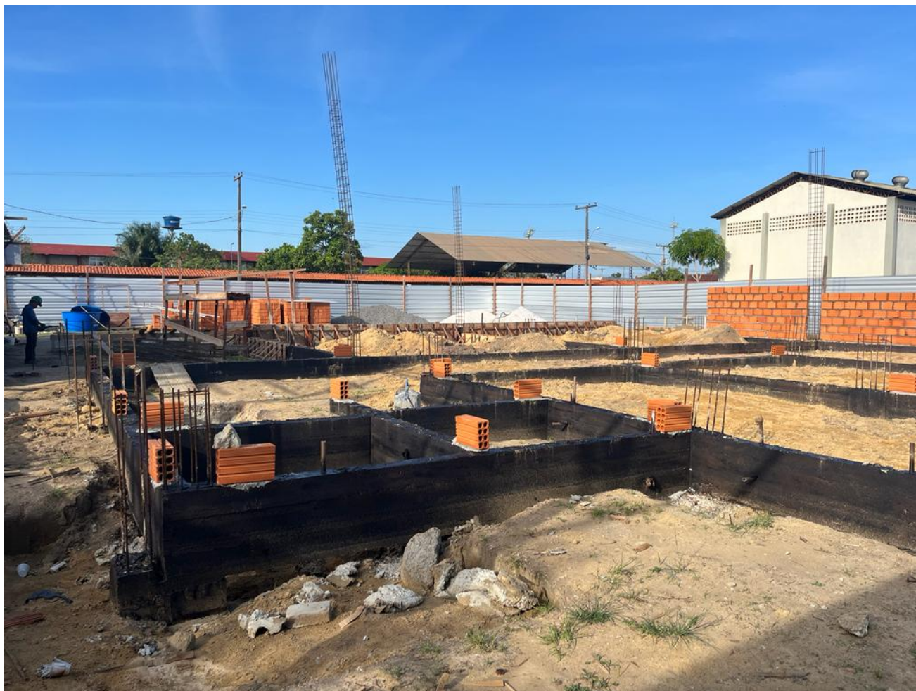
Foto 16 – impermeabilização vigas baldrame 12.12.2022
