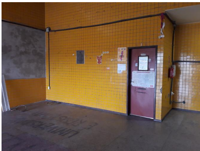
Frente do Imóvel avaliando 01 Fonte: DMANUT
