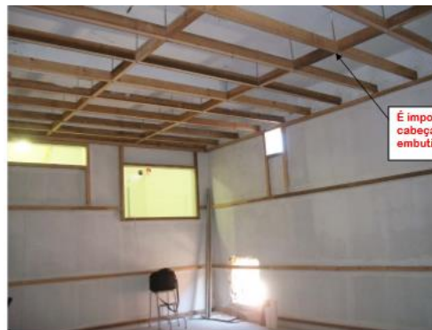
Figura 15: Exemplo de madeiramento para sala de exames
