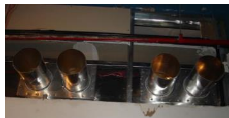
Figura 16: Exemplo de abertura na alvenaria para passagem dos guias de onda
