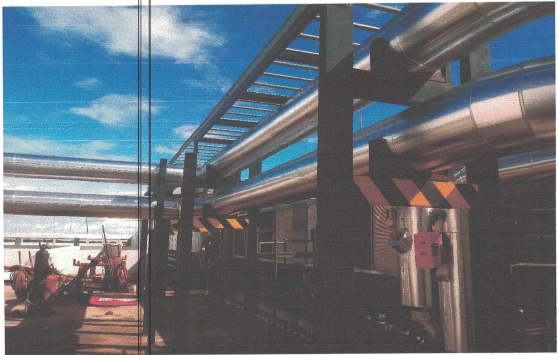
Sistema de solamento térmico do chillers.
